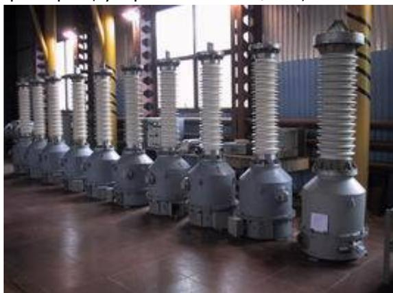
Внутренняя полость трансформатора заполняется элегазом, служащим изолирующей и тепло-отводящей средой. Заполнение трансформатора элегазом производится через клапан, установленный на корпусе трансформатора.
